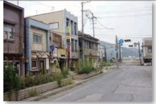
津波による被害を受けた市内の様子
