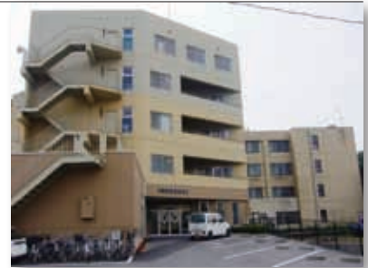
津波で1階部分を被災した港湾病院
